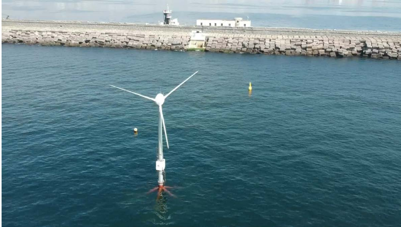
Turbina eolica su piattaforma galleggiante presso Molo S. Vincenzo - Napoli
