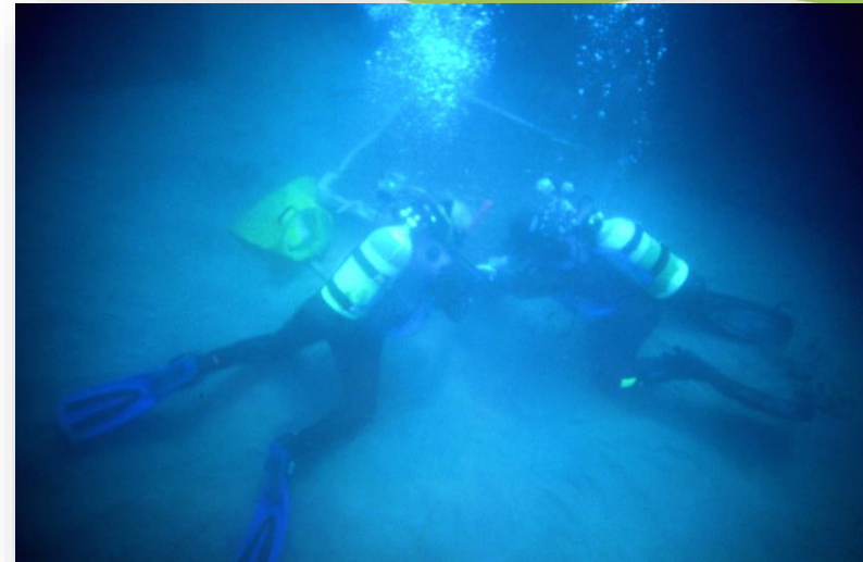
Posa in opera del materasso sul fondale (da F. Boccalaro, 2006)
